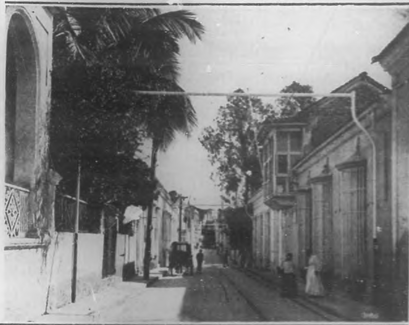
CALLE SAN BASILIO EL MAGNO
